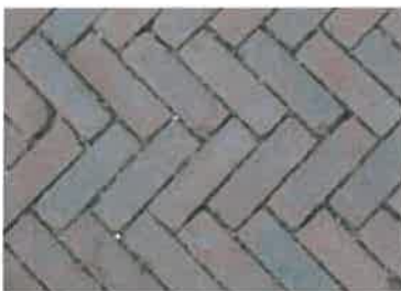
rijbaan en trottoir in gebakken klinker
